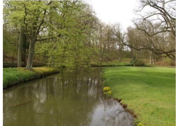
Deze oeverzone heeft van oorsprong geen beschoeiing. Door afkalving en schade verloopt de oeverlijn en dat vraagt wel om regelmatig onderhoud.
