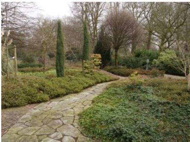
Een flagstonepad in een stadspark. De flagstonestegeels zijn met cement gevoegd. Hierdoor komt er geen onkruidgroei op voor. Het pad watert naar de zijkanten af.
