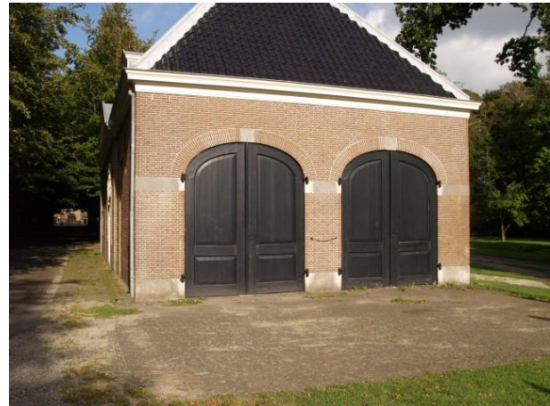
Kleine onregelmatigheden door zettingen in oude verharding dragen bij aan het gevoel van authenticiteit; reparatie is alleen nodig als dat voor de instandhouding en het gebruik noodzakelijk is.
